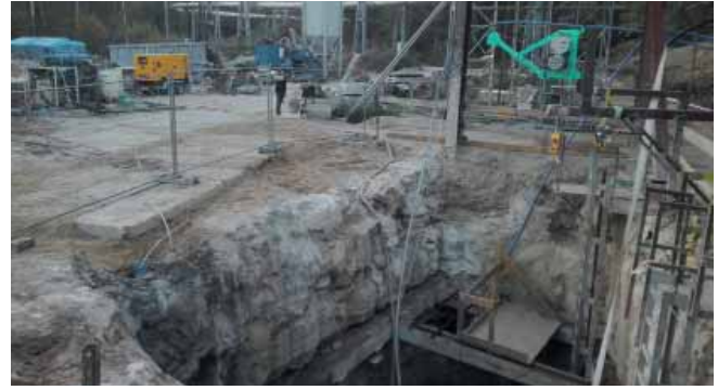
FOT. 2. | Widok placu budowy w trakcie robót
