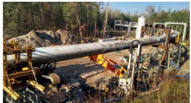
FOT. 3. | Stabilizacja gruntu wokół komory (jet grouting)
