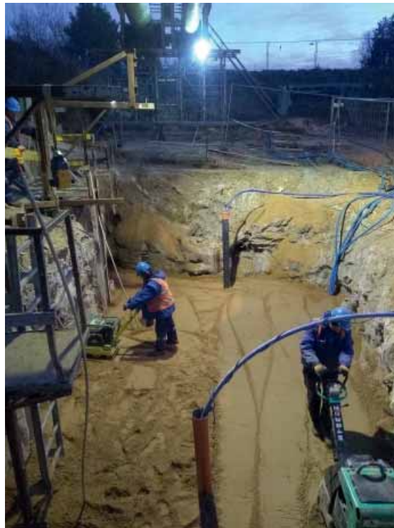
FOT. 6. | Widok placu budowy po zakończeniu robót z nową podporą rurociągów napowietrznych posadowioną na zasypanej komorze naprawczej
