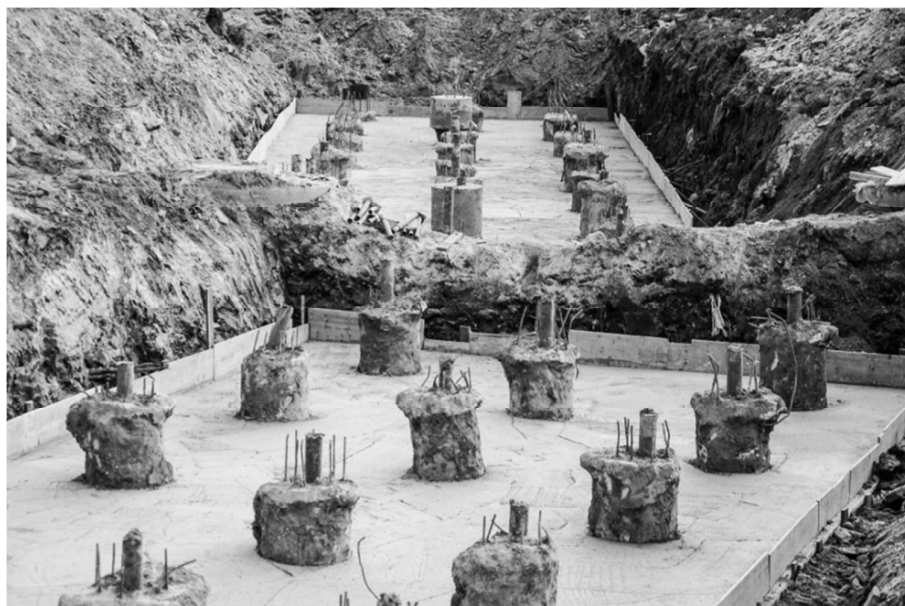
Rys. 23. Głowice pali CFA IS (przed skuciem) na Obwodnicy Marek
