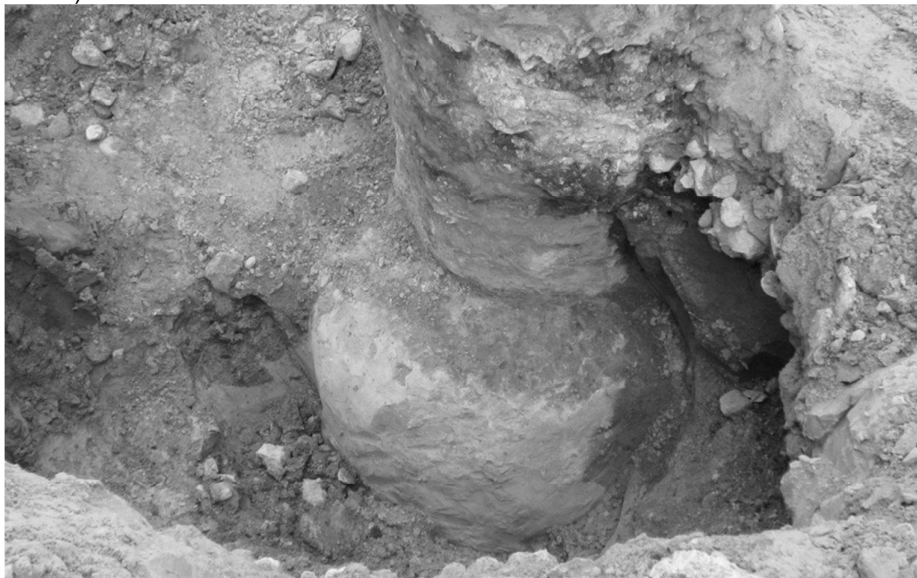
Rys. 10. Próbnny pal CFA IS
