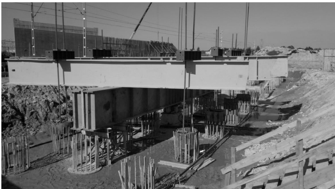
Rys.3. Próbné obciążenie pala IS \varnothing 1000/1500 węzła Salomea
