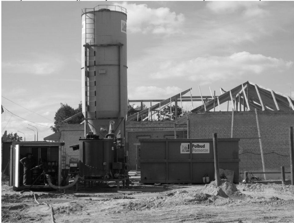
Rys. 9. Zestaw do iniekcji strumieniowej na terenie cukrowni
