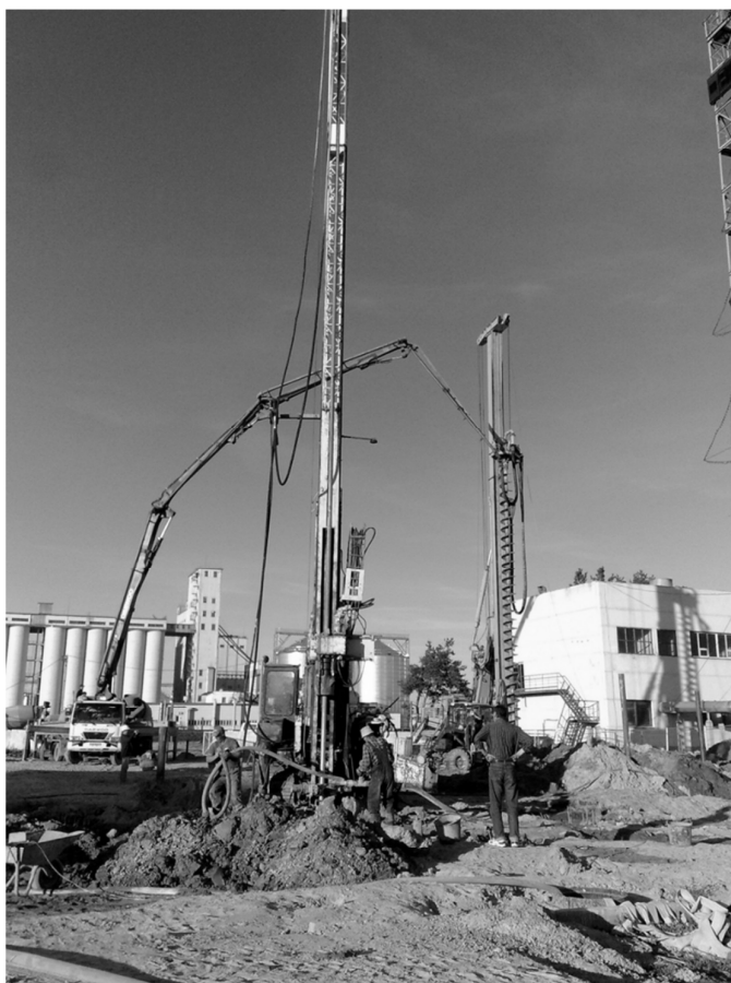
Rys. 8. Wykonywanie pali CFA IS na terenie cukrowni
