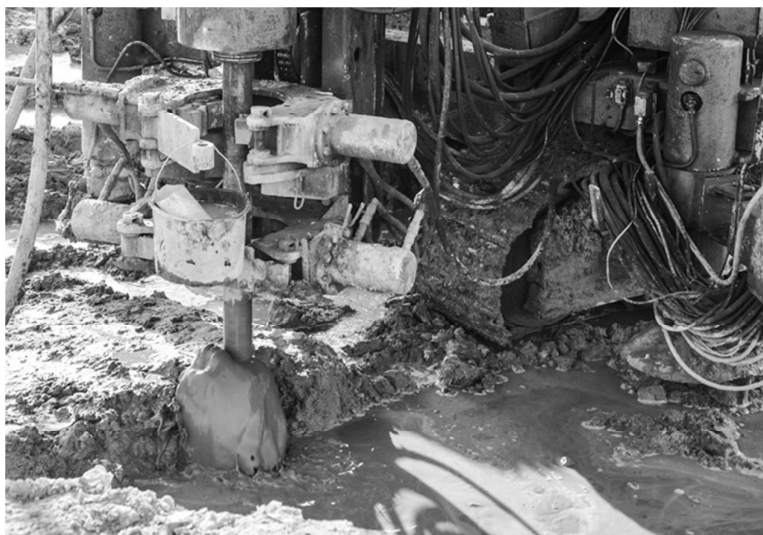
Rys. 22. Wykonanie pali CFA IS
